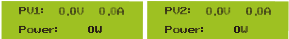
Pic 8.3 Informações sobre tensão e corrente de entrada fotovoltaica
